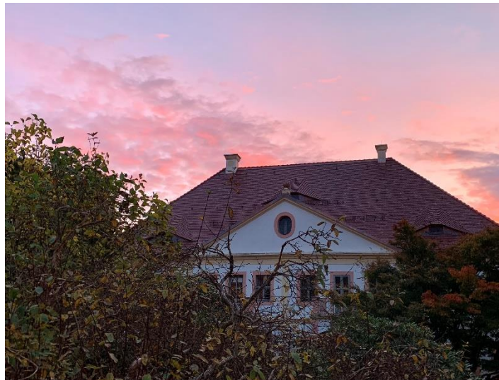
Die Propstei in der Morgensonne – ohne Gerüst – mit neuem Dach
